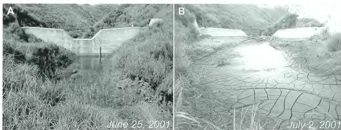
写真-1 2001年6月29日災害前後における治山ダムの土砂堆積状況（黒川第1支流試験流域）
