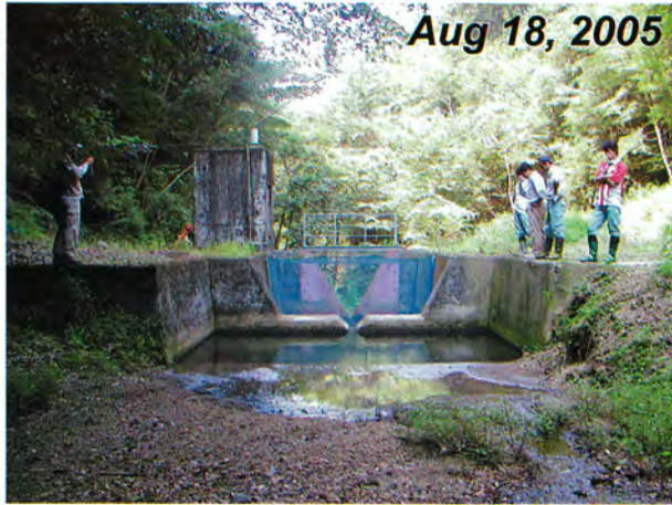
写真－1 台風14号豪雨による土砂堆積前後の量水施設の状況（2号沢）
