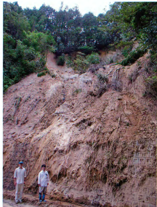
写真－4 去川国有林内林道沿いのシラス崩壊 （上部の崩壊部分だけがシラス）
