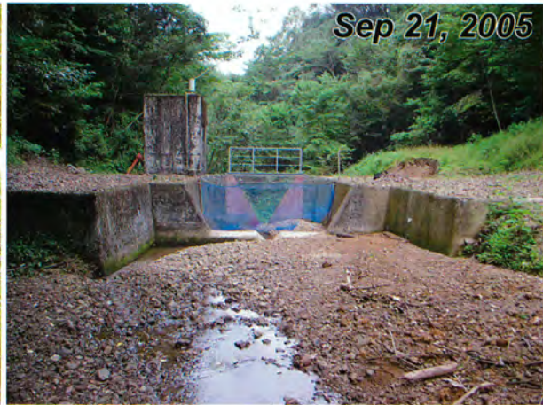
写真－1 台風14号豪雨による土砂堆積前後の量水施設の状況（2号沢）
