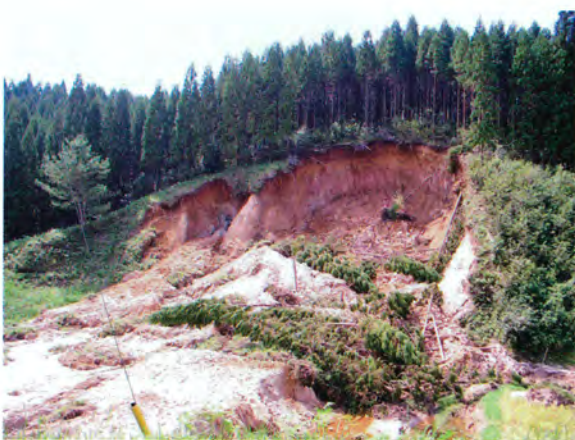
写真－3 シラス（入戸火砕流堆積物）分布域で の斜面崩壊（高岡町和石付近）
