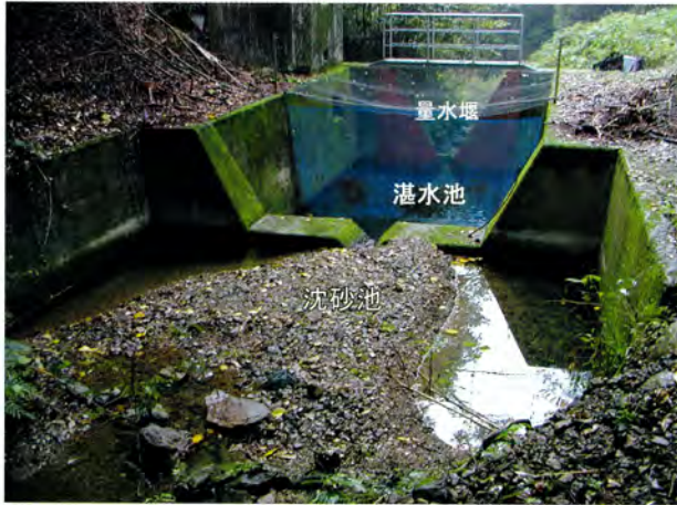
写真-1 去川森林理水試験地1号沢量水施設の湛水池と沈砂池 (2005年10月撮影)
