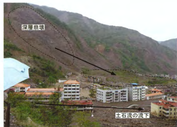
写真－4 深層崩壊と土石流の流入
