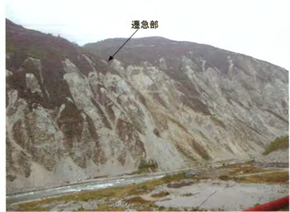
写真－2 遷急部付近から発生した表層崩壊群
