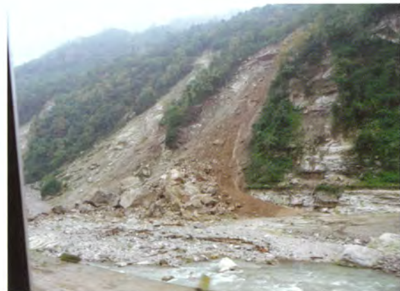
写真－3 岩塊を多く含む崩壊
