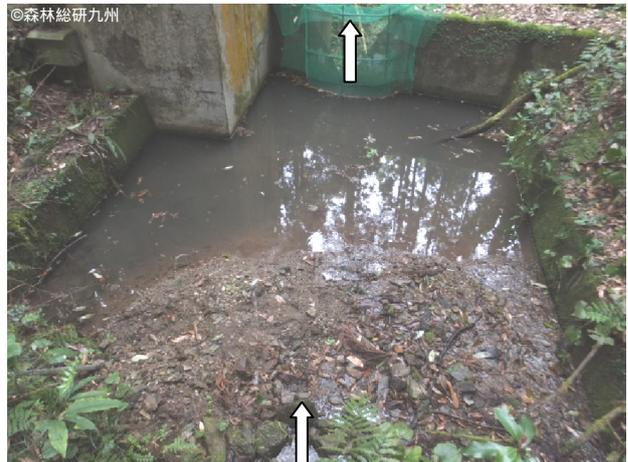
写真—1 鹿北 I号沢の沈砂池の排土前の土砂の堆積状況 (2013年4月23日時点)。写真の下側中央部から沈砂池へ流入した水は、写真の上部中央ノッチ部から越流する。
