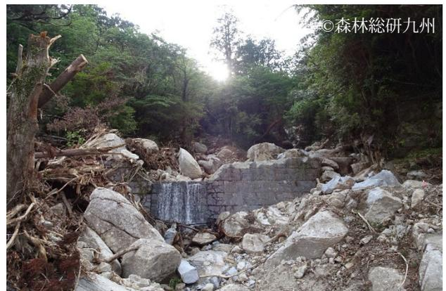
図-1 屋久島公園安房線沿いの崩壊地下部に設置されていた治山ダムの損壊状況
