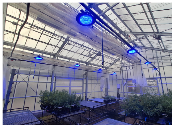
写真3 LED照明装置
