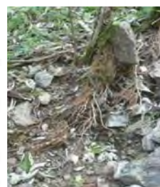
根系による 崩壊防止の様子
