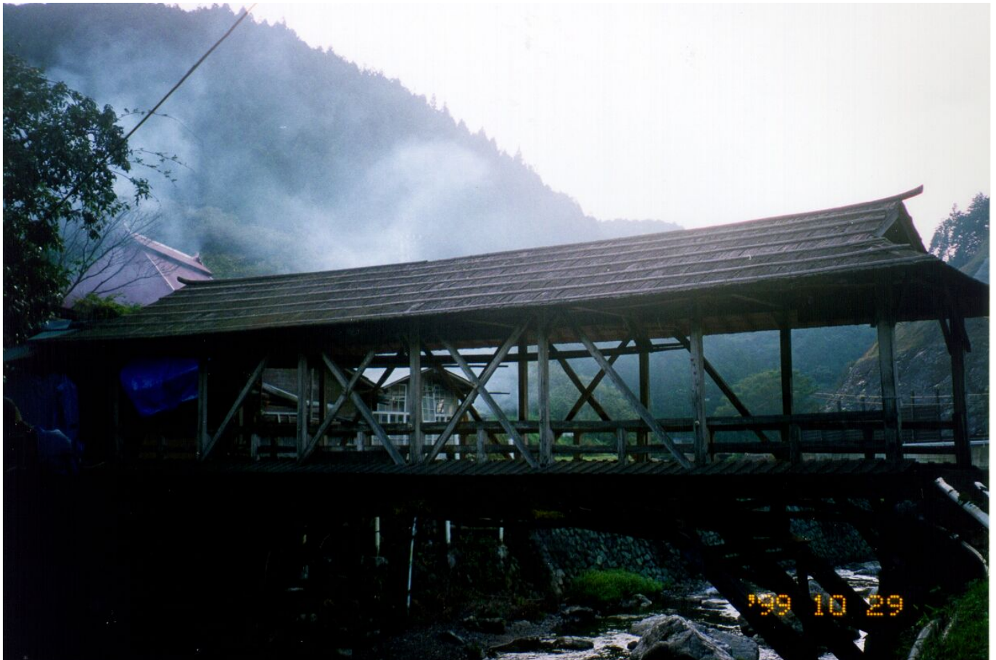
愛媛県喜多郡河辺村(現大洲市)にある三嶋橋。 大正 12 年(1923)架橋。 橋長 14.8m、幅員 2.6m。 屋根は杉皮葺き。今なお日常的に軽トラックが渡っている。
