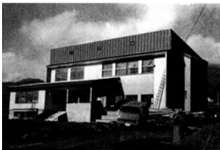
岡山小学校羽広山分校 昭和53年11月竣工 回顧と展望 岡山小学校.p3
