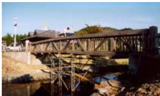
写真4 載荷実験の様子（2号橋）
