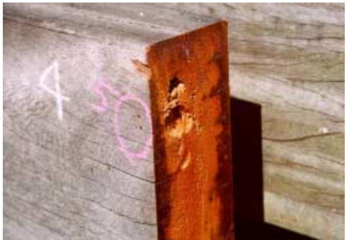
写真4 トラス下弦材の母材切断面
