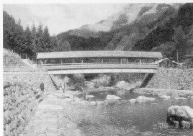
写真9 愛媛県喜多郡河辺町「龍王橋」
