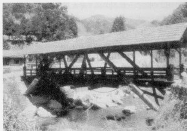
写真7 愛媛県喜多郡河辺町「帯江橋」
