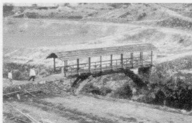
写真5 愛媛県喜多郡内子町「田丸橋」
