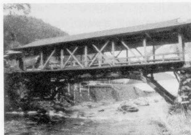
写真6 愛媛県喜多郡河辺町「三嶋橋」
