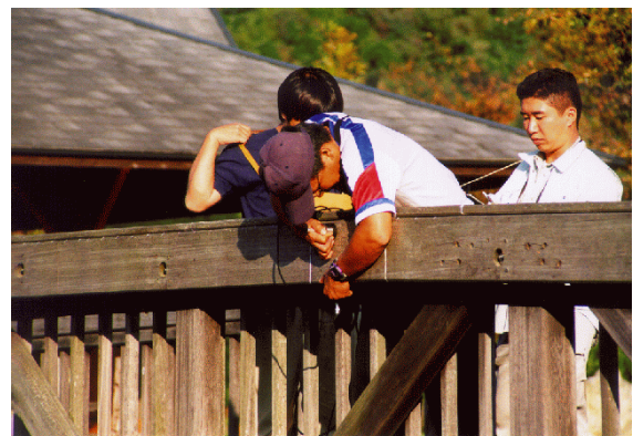
写真 5 現存橋上弦材の超音波伝播速度測定
