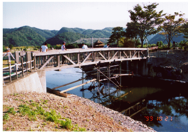
写真8 現存橋の調査(2号橋)
