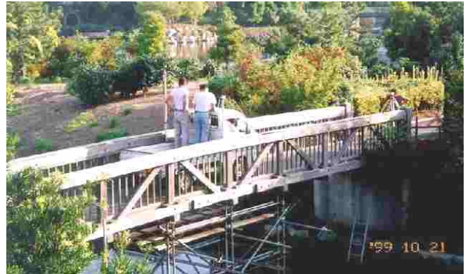
写真 3 現存する 1 号橋の載荷実験風景
