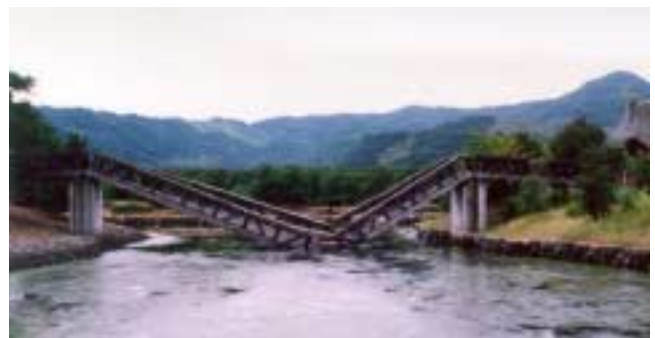
写真 1 4 号橋落下直後の様子
