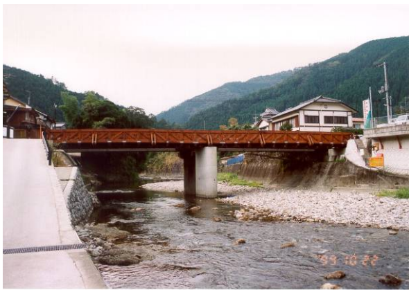
写真2 高知県梶原町六根の橋。建設省モデル木橋として1996/03架橋。1999/10/22撮影。
