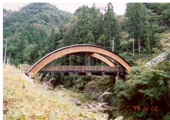
写真3 愛媛県広田村神の森大橋。スギ集成材を使った20tトラックが渡れるアーチ橋。1994/05架橋。1999/10/22撮影。
