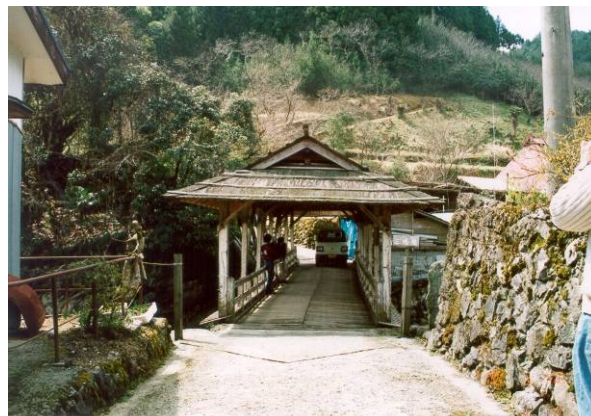
写真1 愛媛県河辺村三島橋。日常生活の中で使用される木橋は、実用的な性能を使用者自身が維持しつづける。2000/03/30 撮影。
