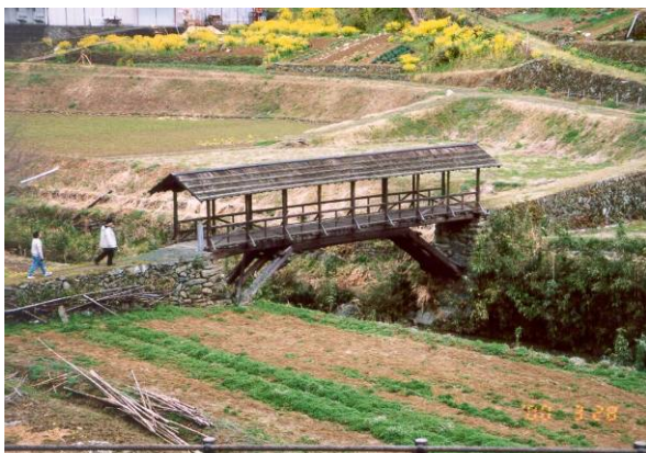
写真4 愛媛県内子町田丸橋。農村風景の中で生き続ける木橋は、屋根の葺き替えや部材交換で同じ形を維持しつづけている。2000/03/28 撮影。
