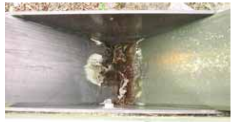
写真 3 格点の内側上から見た斜材の腐朽
