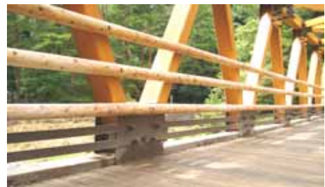
写真 5 フラットバーの留め付け状況
