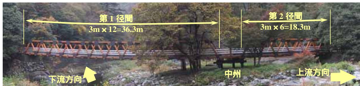
写真 1 対象橋梁の全景(2003/11/06 撮影・4 枚を合成)
