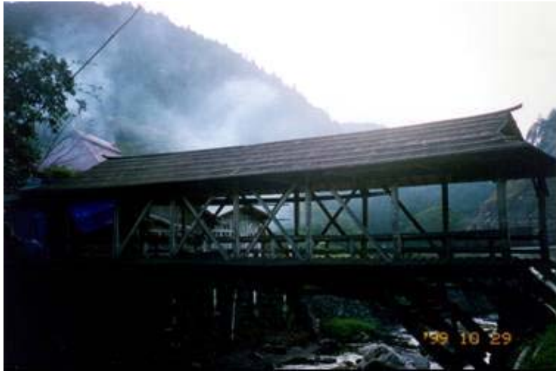
三嶋橋（愛媛県喜多郡河辺村） 大正 12 年(1923)架橋。橋長 14.8m、幅員 2.6m。 屋根は杉皮葺き。日常的に軽トラックが渡っている。
