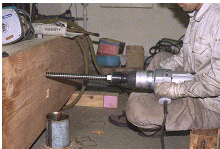
Driving Lag-screw Bolt ラグスクリーボルトの施工
