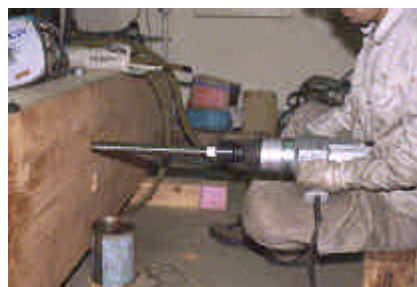
Driving Lag-screw Bolt ラグスクリーボルトの施工
