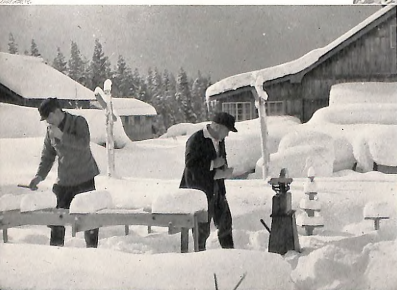
← 模型による冠雪の試験
