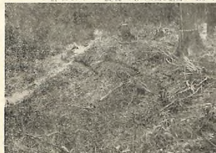
地拵処理後の状況 (A区緩斜面) No. 5
