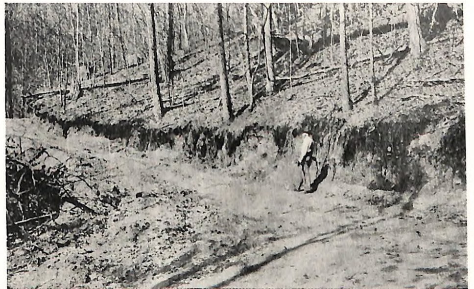
林道 No. 10 流域 流出水汚濁の主原因。林産物搬出のため林道建設が盛である。試験によれば、道路が水質悪化の原因であつた。建設、維持方法の改善が水の価値を保持すると共に、林産物搬出効率を良くするであろう。
