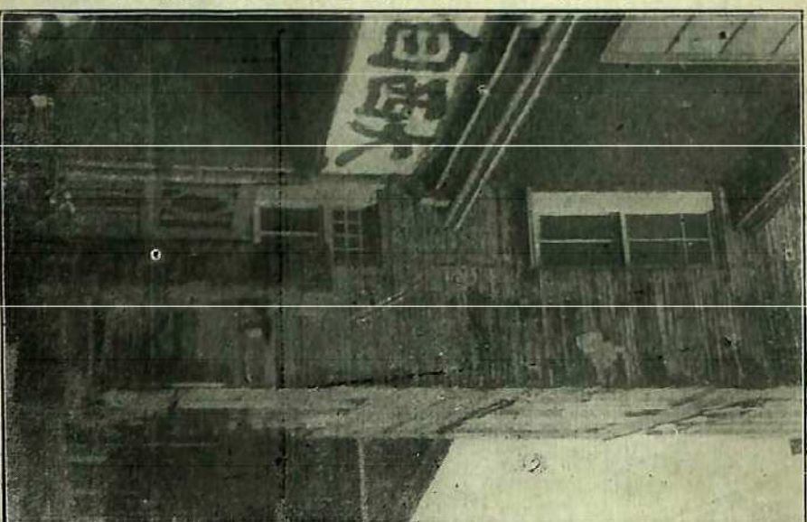
魔布屋一ノ橋附近ニ於ケル木骨「セメント」家屋（大正十二年二月 竣工）ノ「セメント」壁全部剥落シ下地ヲ露出セルモノ
