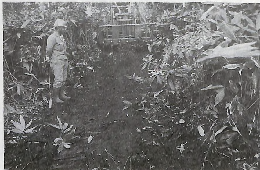
写真-12 試作爪(1)によりササ根系の切断・排除した跡地の1例(幅員平均2.17m)
