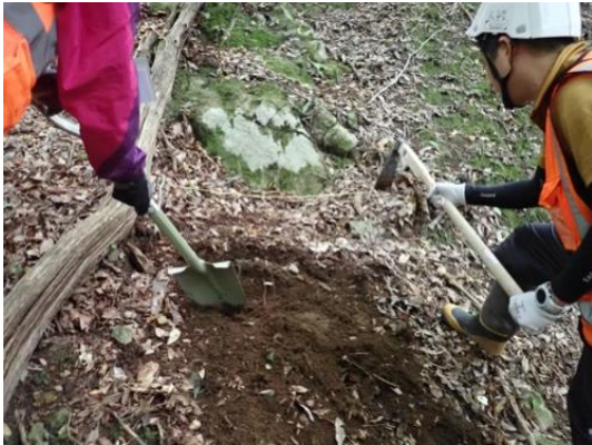
露出した巨礫の手前で断面を作成
