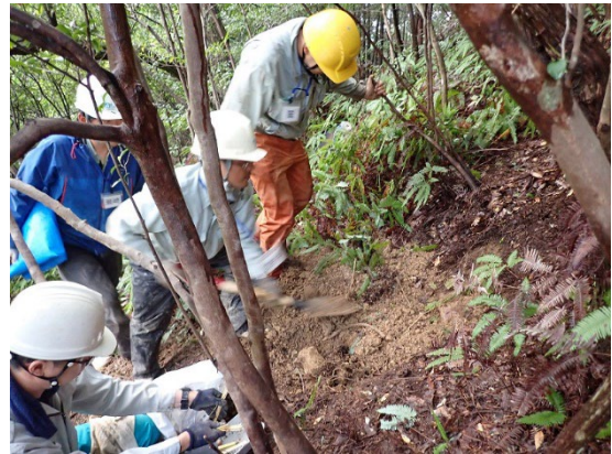
埋め戻し作業
