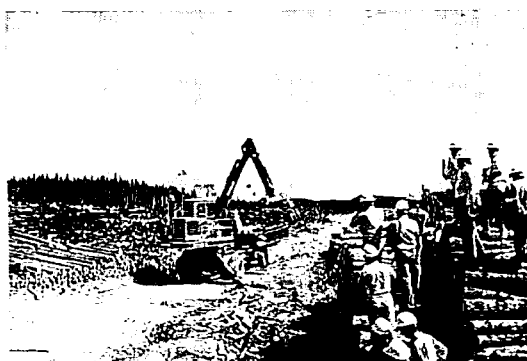
写真-1 スラッシャーによる玉切作業
