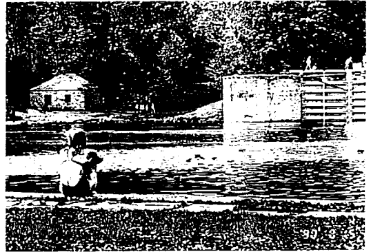
写真-1 Jones Falls の閘門式運河
