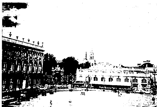
写真-4 スタニスラス広場
