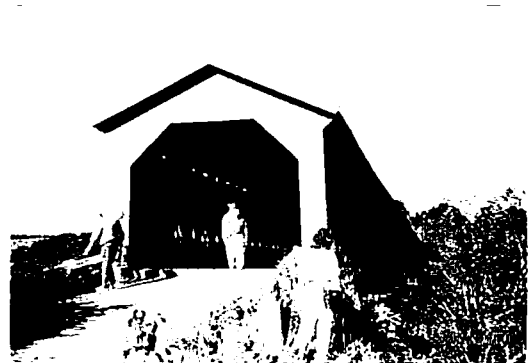
写真-6 1928年に建設された屋根付き木橋
