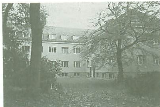
写真-1 オーストリア国立林業試験場本部建物 (ユフロ本部は右手前に突き出した部分の 2 階、ゲスト・ルームは同 3 階の屋根裏部屋にある)
