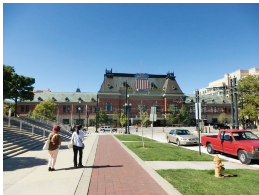
写真-1 ユニオンパシフィック鉄道の旧駅舎
