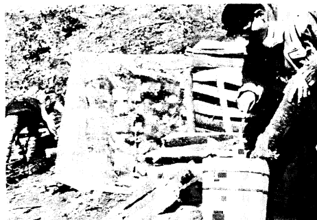
2. 塗布法による処理
