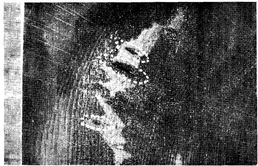
Phot. 8 高圧処理によるクラック Crack caused by high pressure treatment
