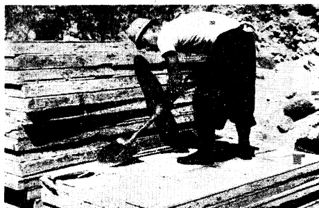
写真 32 パネルのセメント落し
