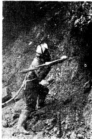
写真3 普通土砂切取り(ツルハシ)
