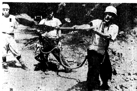
写真8 土砂投げ(ショベル)
