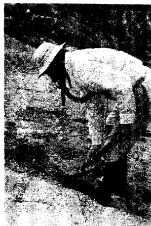
写真 14 裸地の階段切付け (ショベル)
