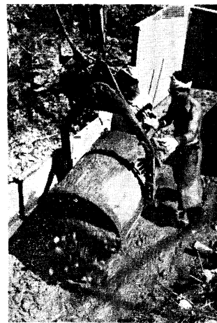
写真 30 コンクリートのクレーンによる運搬
