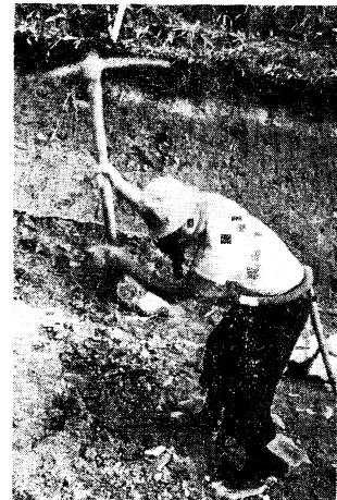
写真4 礫交り土砂切取り (ツルハシ)
