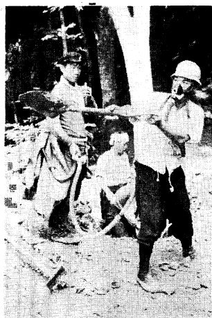
写真9 土砂投上げ(ショベル)
