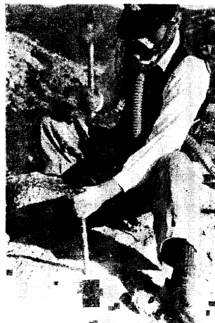
写真 16 縦孔明け (ハツパノミ、セツトウ)
