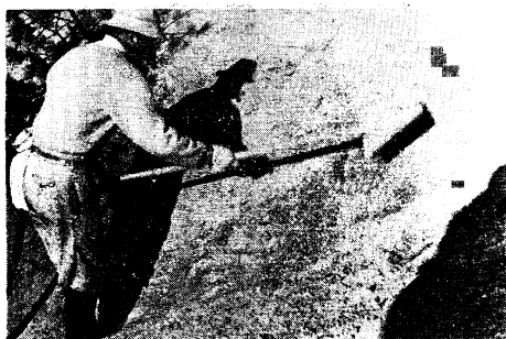
写真 35 水路面の突固め
