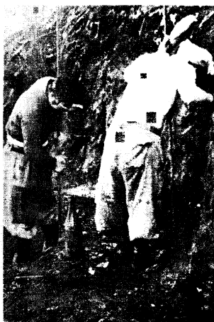
写真 17 縦孔明け (突タガネ)
