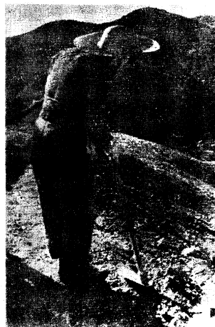
写真 15 階段面の仕上げ (ジョレン)
