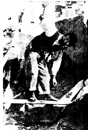
写真 18 横孔明け (ハツパノミ、セツトウ)
