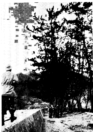
写真 9. 熊野市新鹿 防潮堤と防風林
