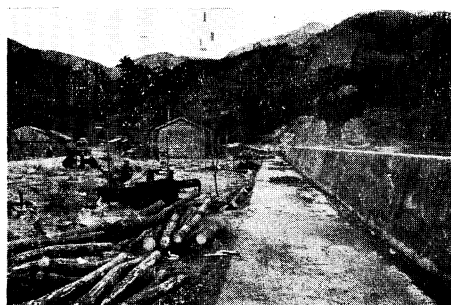
写真 12. 前に同じ 防潮堤と家屋全壊跡
