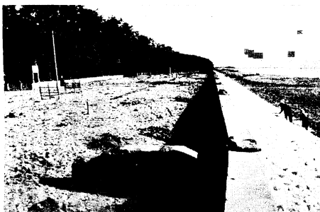
写真 37. 鈴鹿市千世崎 防潮堤と防災林
