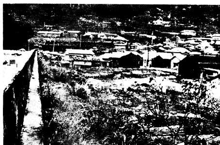
写真 14. 熊野市新鹿 写真 13 の堤内地 家屋全壊跡
