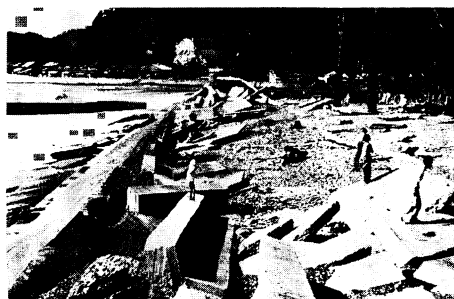
写真 20. 長島町東長島呼崎 防潮堤の破壊 (長島町役場提供)
