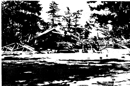
写真 47. 前に同じ 家屋破壊による流木の林帯による阻止
