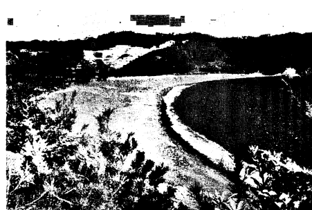
写真 28. 長島町古里 防潮堤と防潮林
