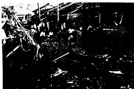
写真 25. 長島町西長島海岸通り家屋の被害 (長島町役場提供)
