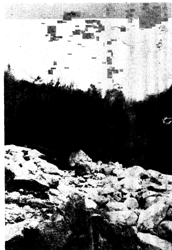
写真 21. 日川大蔵沢の 滑落型崩壊
