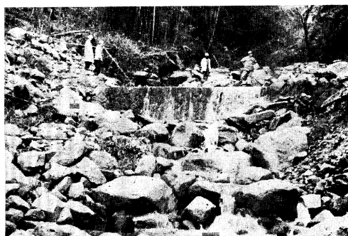
写真 8. 堰堤の土石留止
