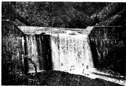
写真 34. 戸川増穂堰堤
