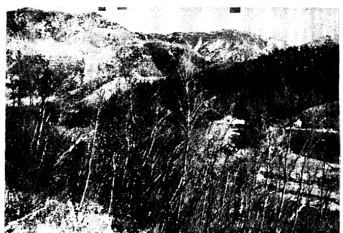
写真 6. 雁坂峠方面の散在する崩壊
