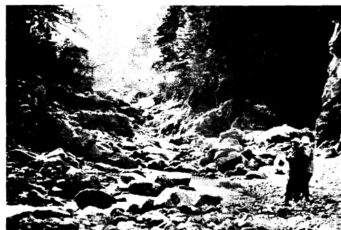
写真 31. 大武川の空積堰堤の破壊
