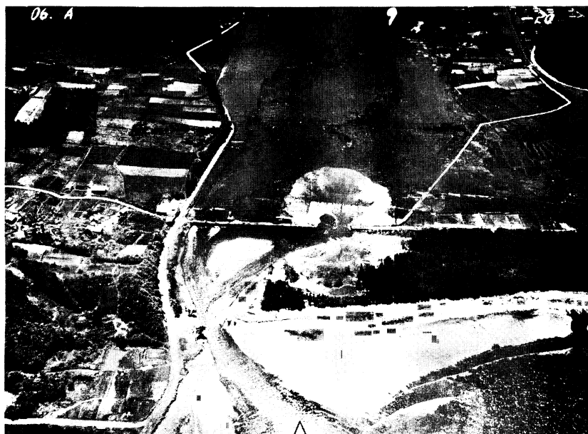
写真21. 岩手県下閉伊郡山田町船越字浦浜 津波のひいた直後の状況、林帯切れ目背後の防潮堤の欠壊 および水田の被害（陸上自衛隊提供）。
