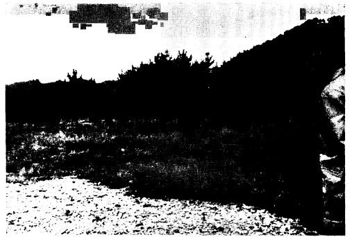
写真28. 岩手県釜石市唐丹町本郷 疎開した防潮林。
