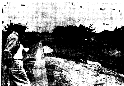
写真50. 宮城県本吉郡本吉町沖ノ田 大堰川口の護岸，上流にはない。
