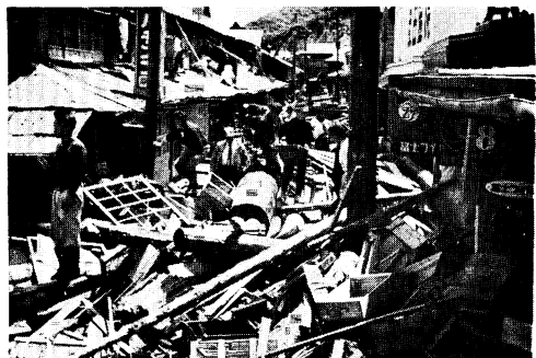
写真63. 宮城県牡鹿郡女川町 市街道路を埋めた漂流物（女川町役場提供）。
