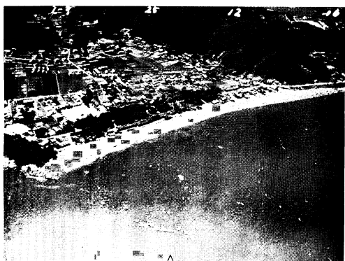
写真10. 岩手県宮古市磯鶏 改良を要する林帯，林帯前に進出した 家屋および津波による流材（陸上自衛隊 提供）。
