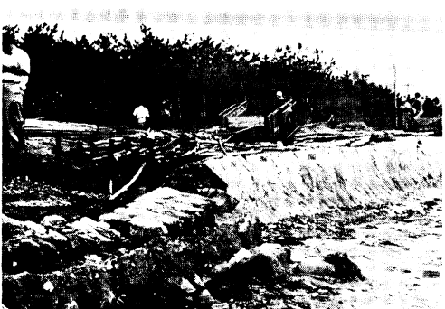
写真48. 宮城県気仙沼市階上字波路上 石積護岸の欠壊、この背後は林帯が消滅して いる。
