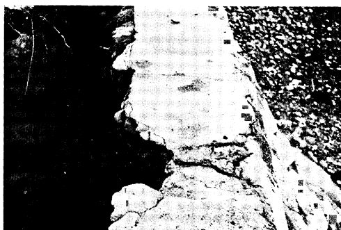
写真49. 宮城県気仙沼市階上字岩井崎 護岸背後の洗掘。
