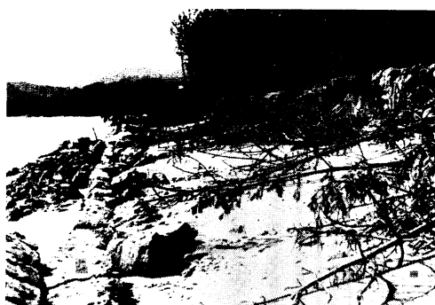
写真43. 岩手県陸前高田市高田松原 石積護岸の欠壊と林縁の侵食(侵食は被災後 も潮流により進行している)。
