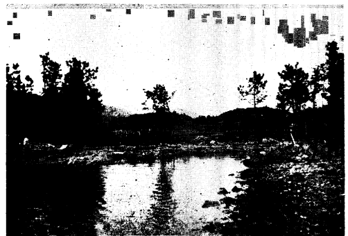
写真58. 宮城県本吉郡志津川町折立 疎開林分の流失とその前面石積堤の流失，背 後で水田流失。
