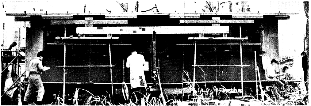
3.7-3 軒先突上げ荷重（ループダイナモメーター使用）
