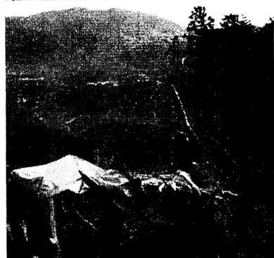
写真 4-5. 第 I 区間から中間支持金具を通過した搬器が自重走行を開始した瞬間
