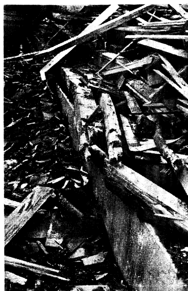
F 306 土台の破損 （鶴岡市 京田小学校、幼稚園）
