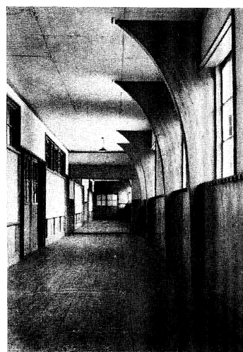
L104 集成材による二階建校舎の二階廊下（新潟県西蒲原郡 吉田中学校）
