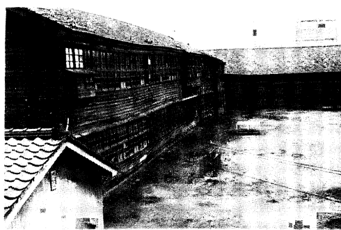
B108 新潟市 白新中学校校舎東面と屋内運動場
