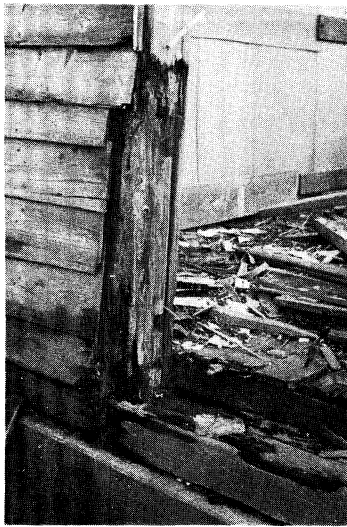
I 305 腐朽・柱と土台 （鶴岡市 京田小学校一幼稚園）
