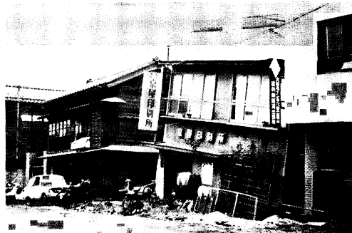
A114 隣接建物の沈下による被害
