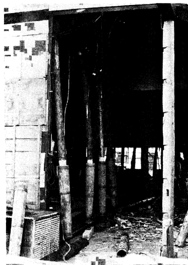
J 202 民家の修理状況（新潟県岩船郡 神林村塩谷 瀬賀氏宅）
