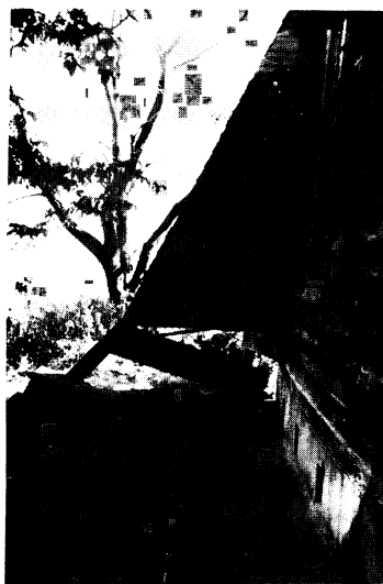
F 212 防火壁に添えつけた柱が ボルト位置で折損 (村上市 岩船小学校)
