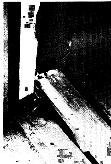
G111 昇降口の接合部の破損 （新潟県立与板高等学校屋内運動場）
