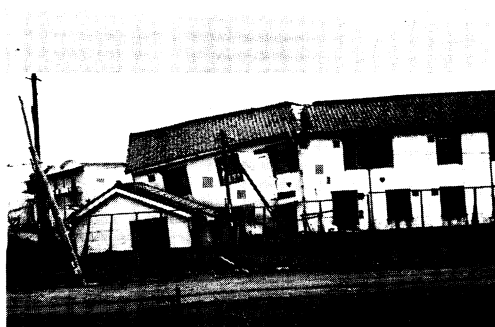
D107 二階建建物接続部 （新潟海上保安本部一中央埠頭）
