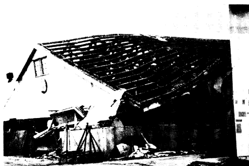
C 101 日通倉庫の倒壊（新潟市中央埠頭）
