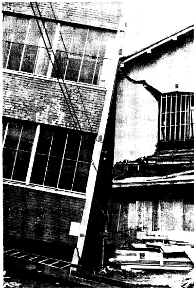
A115 隣接建物の沈下傾倒による被害 （東新潟一明大 杉山研撮影）
