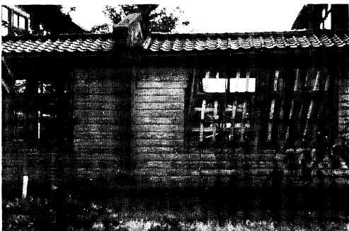
D103 渡廊下の防火壁接続部 (新潟鉄道教習所)
