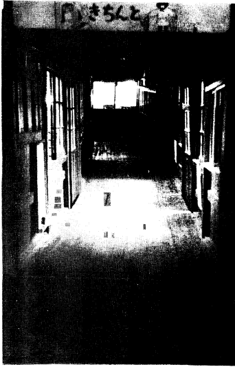
G307 廊下の変形（鶴岡市 西郷小学校）
