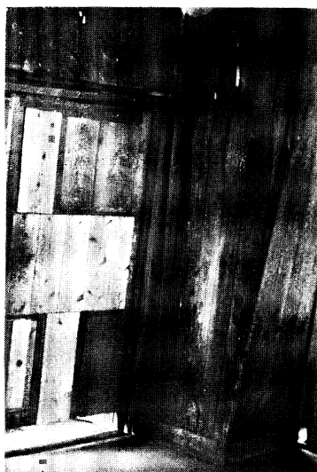
F 111 柱の包み板の破損 (新潟市 白新中学校屋内運動場)
