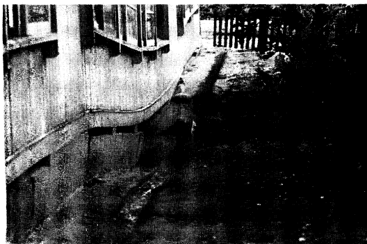
A 103 陥没（新潟市川岸町 身体障害者更生所）
