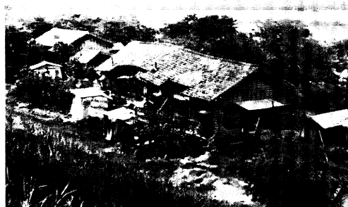
C 102 水道局公舎の不同沈下（新潟市青山）
