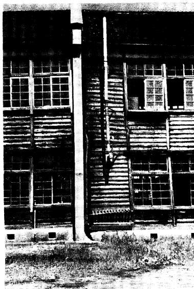
D309 防火壁との接続部の被害 （鶴岡市立 西郷小学校）
