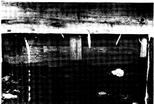
E210 独立基礎の沈下 (村上市 岩船小学校床下)
