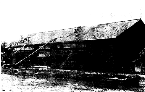
B105 新潟市 曾野木小学校屋内運動場
