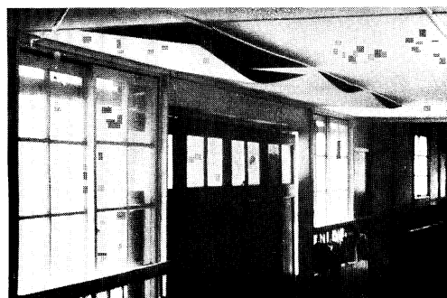
H202 天井板(合板)の破損 (村上市 岩船小学校廊下)
