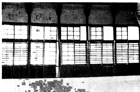
F 320 屋内運動場の被害 (鶴岡市 西郷小学校東屋内運動場)
