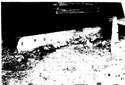
E105 布基礎の浮上 (公営住宅, 新潟市藤見町)
