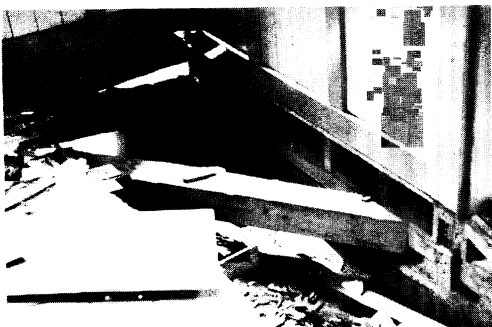
F 104 土台付近の破損状況 （新潟市 曾野木小学校）
