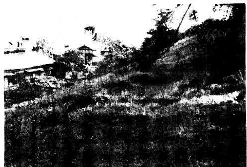
A111 砂丘斜面上の断層状地割れ (新潟市青山 水道局公舎裏)
