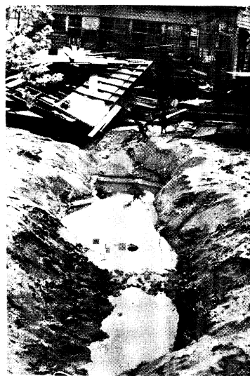
A 104 地下水の噴出孔 （新潟鉄道教習所）
