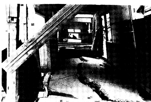
E111 コンクリート渡廊下の亀裂 (新潟市 曾野木中学校)
