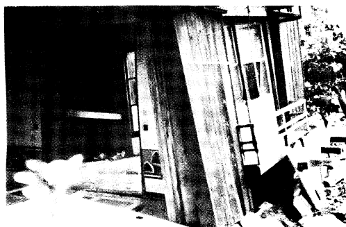
C 103 公営住宅の被害（新潟市藤見町）
