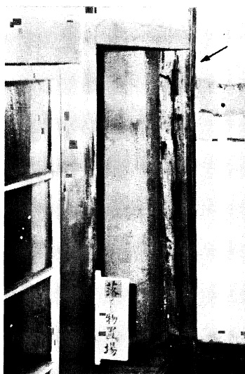
F 212 防火壁に添えつけた柱が ボルト位置で折損 (村上市 岩船小学校)
