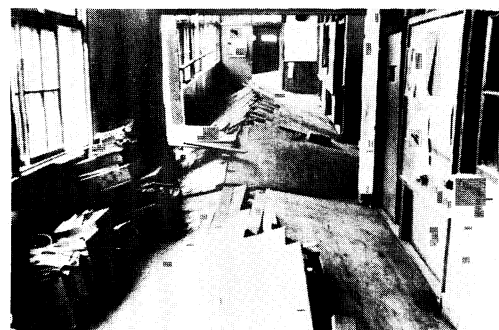
G 104 廊下の変形 (新潟市 曾野木小学校, 同校より借用)
