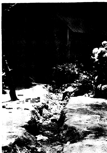
A 101 校庭の地割れ （新潟市 曾野木小学校）
