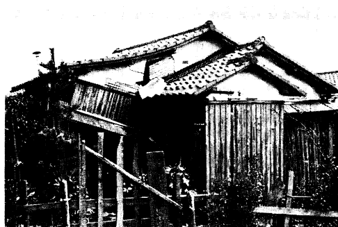
C 104 公営住宅の被害（新潟市藤見町）
