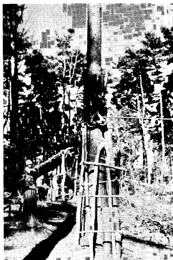
写真1-2. 下方支点（三角滑車）と主索張力測定中の試験員
