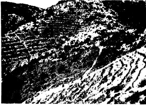
Phot. 72 防止工法 7 号区 (階段なし, クロマツ・ヤマモモの苗木植栽) の施工翌年の状態 (1961 年 6 月 2 日)
