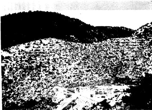
Phot. 74 防止工法 8 号区 (右側) と 9 号区 (左側) の施工当年の状態, いずれも現行の標準的なはげ山化防止工法である。 (1960 年 10 月 20 日)
