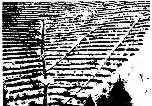
Phot. 11 同上区 (階段状溝切, 法面すじ実播) の施工当年の状況 (1960年10月)
