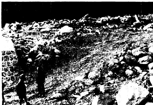
写真 7. 西湖三沢の治山ダムによる堆積
