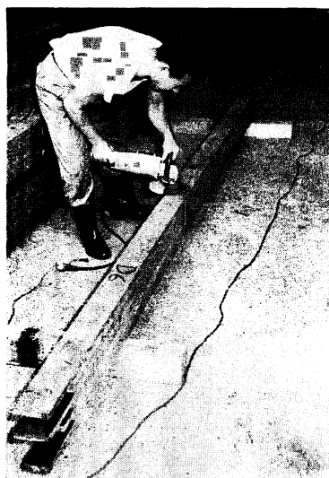
Photo. 2 はみ出した接着剤の除去 Sanding squeezed-out hardened resin.
