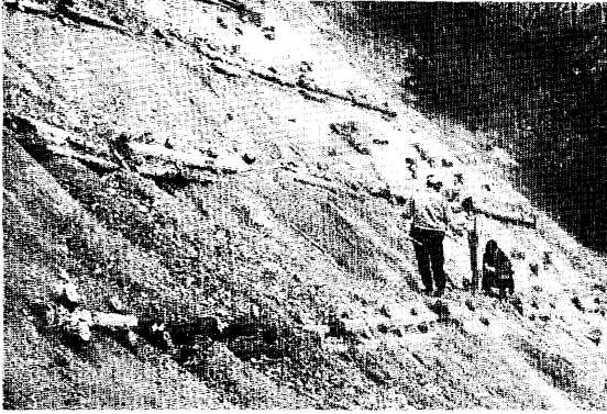
Photo. 16 丸太筋工の埋没状況（5区， 1962年5月14日）
