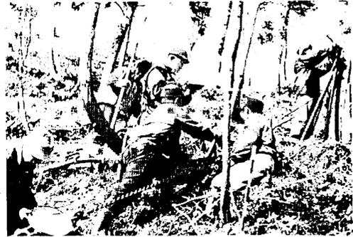
写真 14. 雪圧測定の供試木の引張り試験実施中（伐採更新法の試験地）
