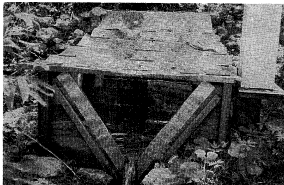
Photo. 10 木堰堤を用いた流出土砂捕そく装置
